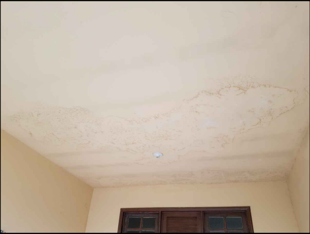
FOTO 01 - Laje da garagem, futura Recepção. Infiltrações na laje de todos os compartimentos.
